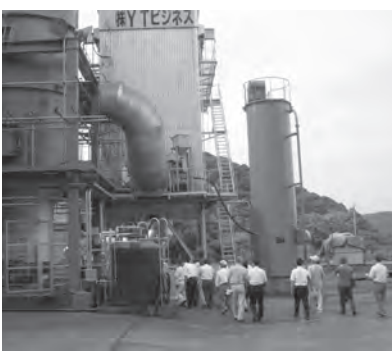
伊豆縦貫自動車道の 工事現場視察
