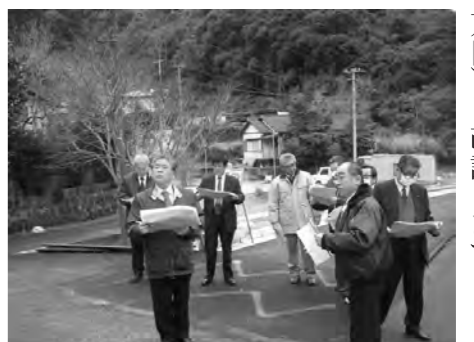
河津下田線(縄地・落合間)の一部完工による現地視察風景
