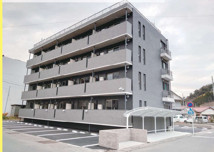
西中に建設されたアパートは津波避難ビルに指定されました
