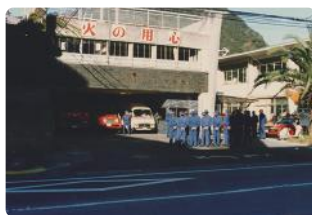
④下田地区消防組合旧庁舎
