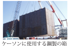
ケーソンに使用する鋼製の箱
