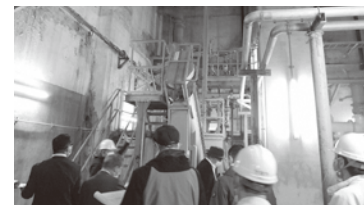
【武ガ浜ポンプ場内現地視察】
