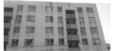
【上河内市営住宅の外壁現状】
