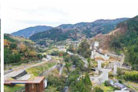
河津IC(仮称)ランプ橋工事
