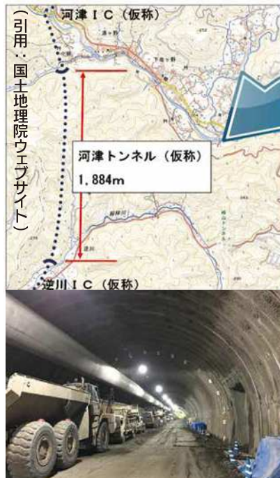
河津トンネル(仮称)工事
