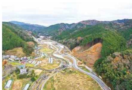
逆川地区国道414号切回し工事
