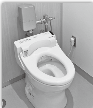
【下田中学校洋式トイレ】
