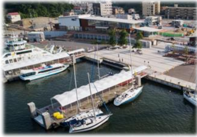
建物との一体的な堤防(気仙沼)
