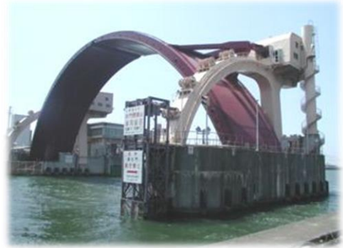
アーチ型の水門 大阪府 出典：大阪府 HP
