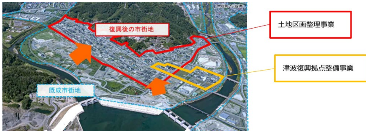
土地区画整理事業による現地高上げと基盤整備の実施（岩手県大槌町 町方地区） 出典：東日本大震災による津波被害からの市街地復興事業検証委員会とりまとめ 令和３年３月３１日
