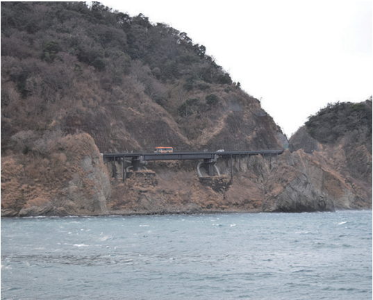
松崎町石部地区 国道136号 富士見橋 （石部港より撮影）
