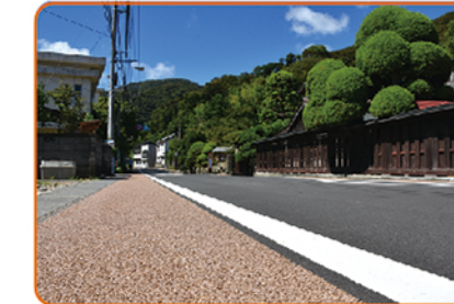
実際に施工したカラー舗装
