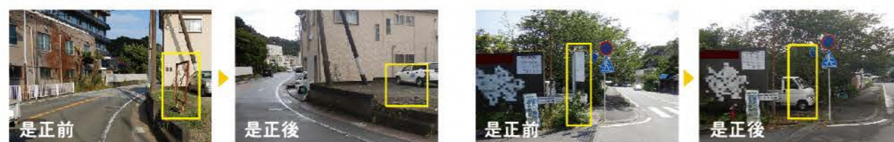
残置された看板の枠を撤去した事例
