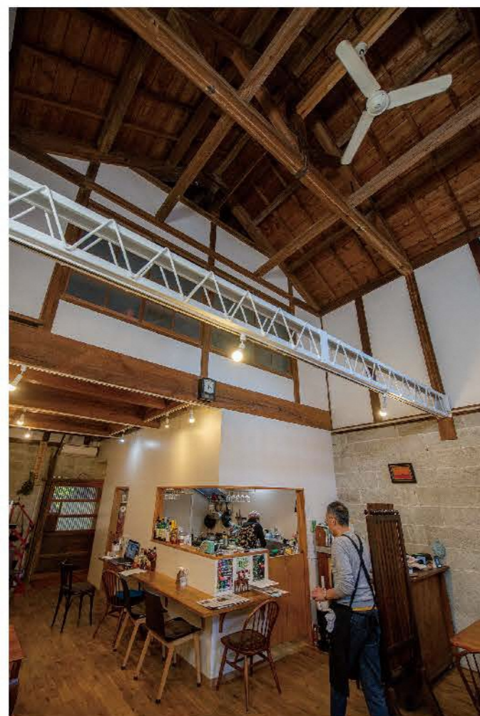
1階の天井を部分的に取り払い、吹き抜けとしたことで蔵の小屋組と天井の高さを体感できる。
