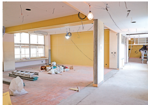
工事中（3階 財務課執務室）
