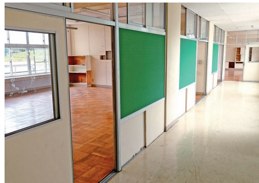
工事前（3階 教室）
