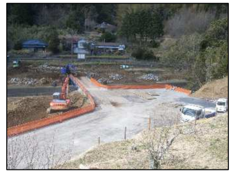
本線橋梁工事
