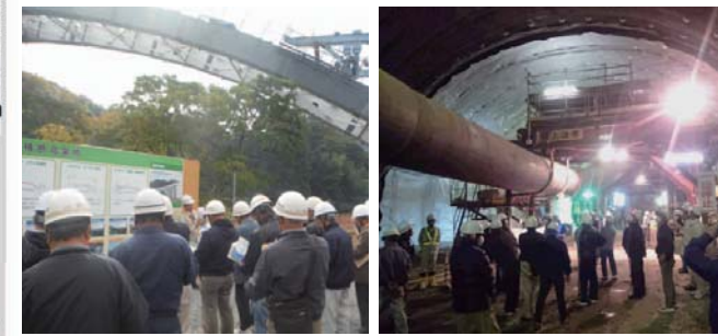
狩野川横断高架橋
