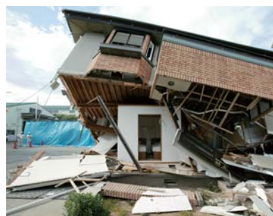
写真中央：耐震シェルター
