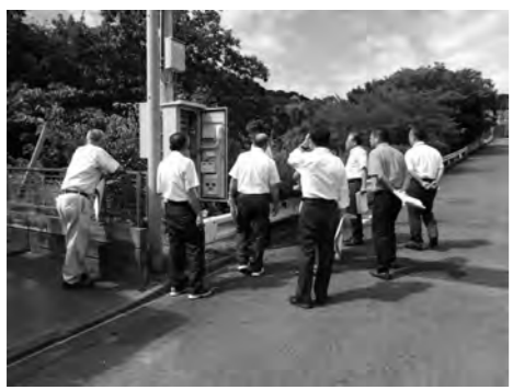
岩下マンホールポンプ
