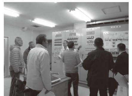
田牛地区排水処理施設
