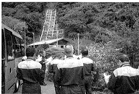
大沢地区上山治山工事施工状況視察
