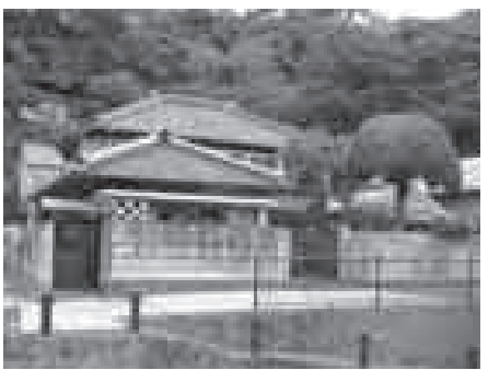
本格的な改修工事が始まる旧澤村邸
